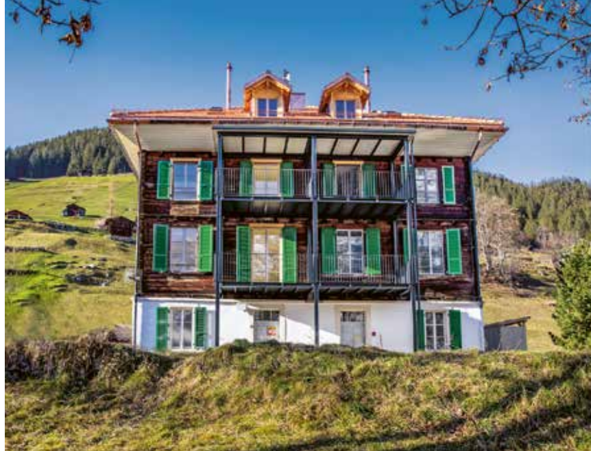
Ehemaliges Schulhaus Gimmelwald nach der Renovierung, Westseite Foto: David Birri, Meiringen
